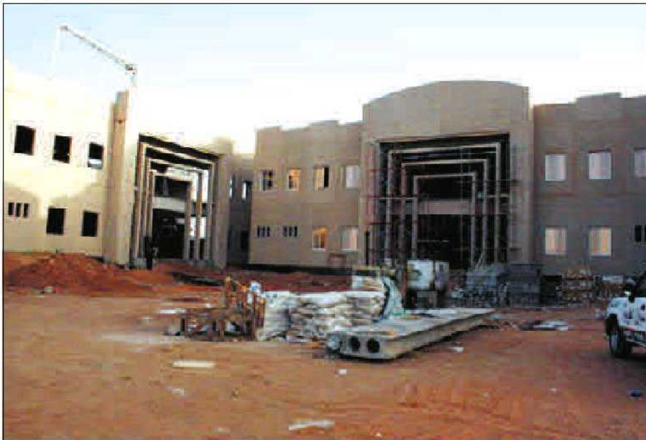
المباني الإدارية بعد شهر يتم تشييدها
