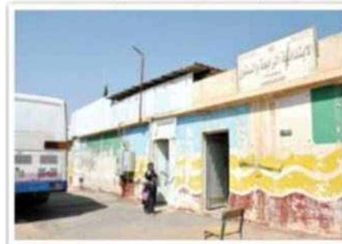
مبنى مدرسي مستأجر ردم وجود مبنى حديث معطل
