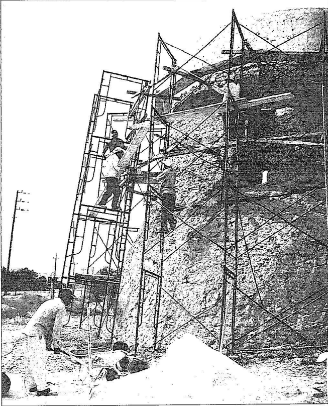
استمرار عملية الترميم للقصر
