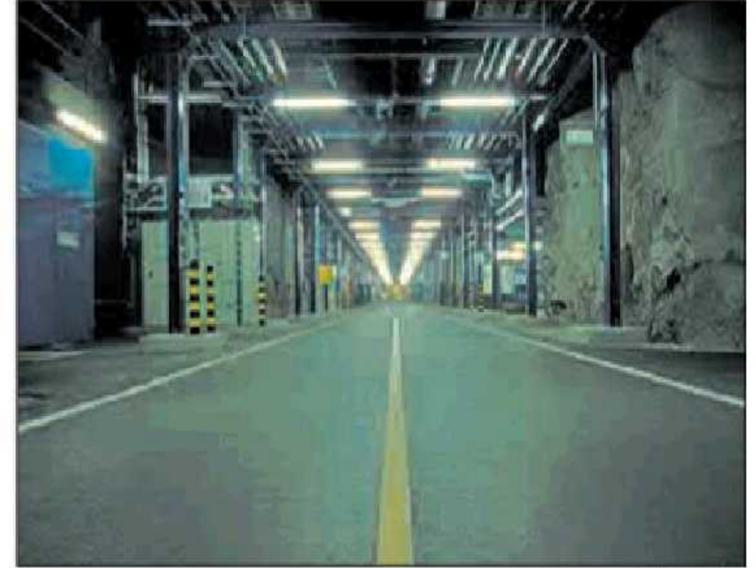
مداخل نفق خط الآباريب
