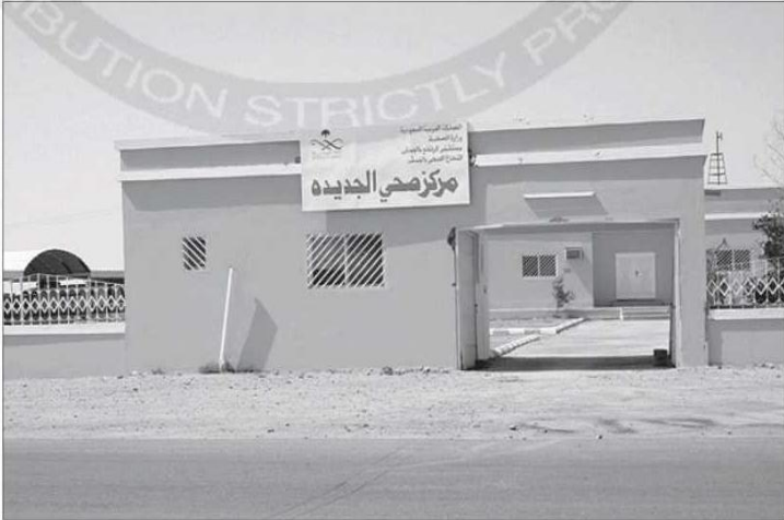
مركز صحي الجديدة
