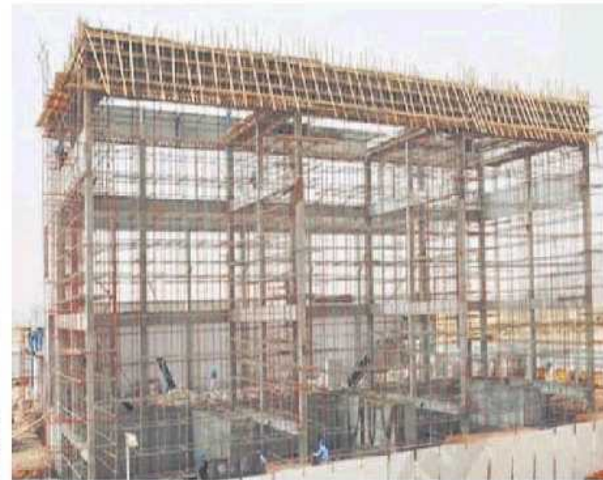
أعمال إنشاء محطة تحويل الطاقة الكهربائية في مدينة سدير للصناعة والأعمال.
