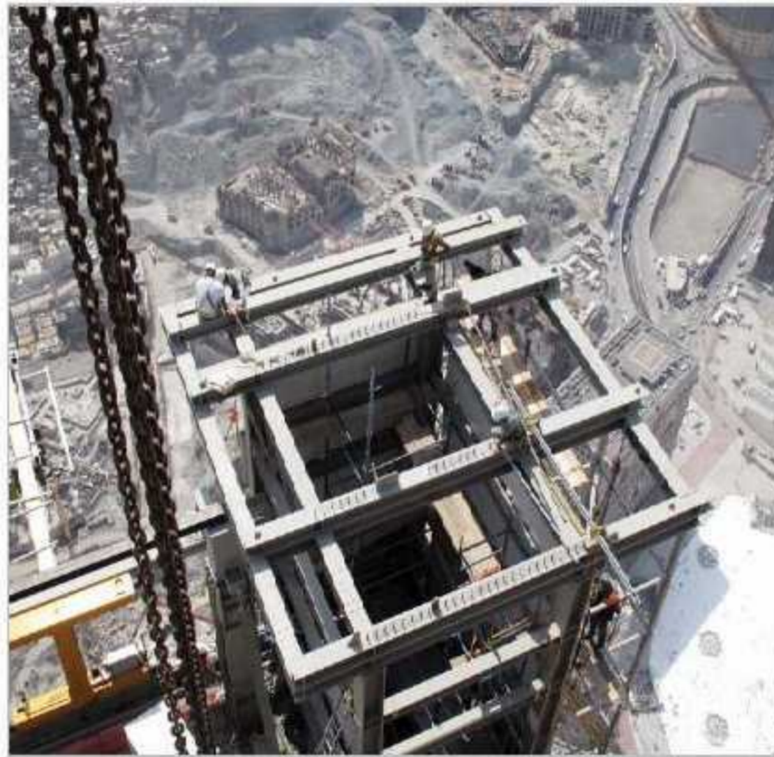
القواعد المسلحة التي تحمل الساعة العملاقة
