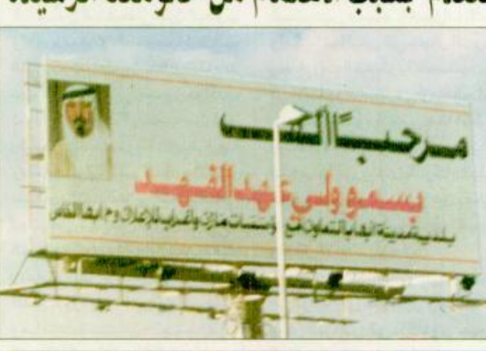
الافتتاح الرسمي لمشروع محطة التحلية وانتاج الطاقة الكهربائية ونظام نقل المياه الحلاة لمنطقة عسير.
