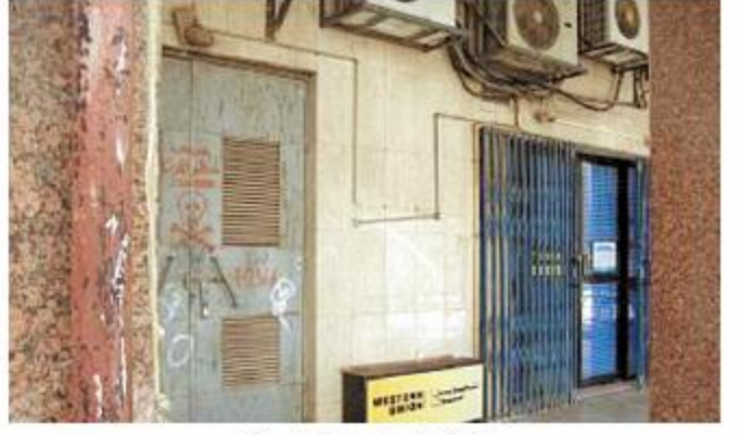
غرفة الكهرباء ومدخل المصرف
