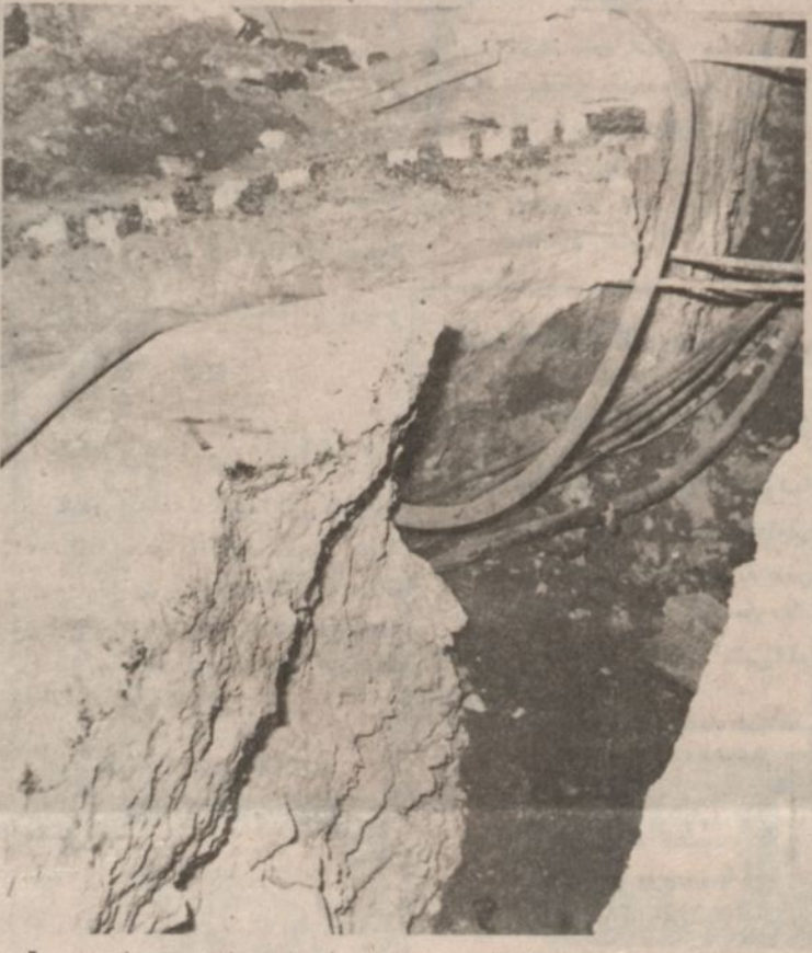
كيبل قوة ١٣٨٠٠ فولت بحي المميز اصابتها آلات شركة «دي في في»
