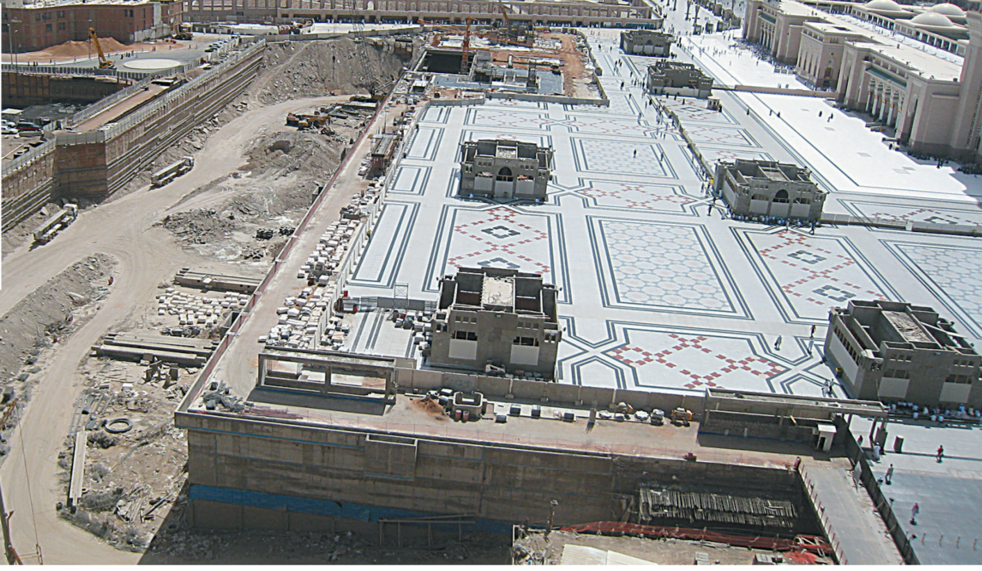
صورة التقطت أمس لمشروع محطة النقل العام والتي يجري تنفيذها شرق المسجد النبوي
