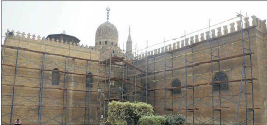
جانب من أعمال الترميم في الجامع الأزهر.
