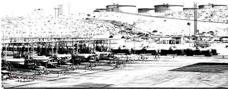
تعد محطة التوزيع الرئيسة في الظهران، نقطة انطلاق خط أنابيب المنتجات البترولية الذي يشق الصحراء صوب الرياض فالقصيم.
