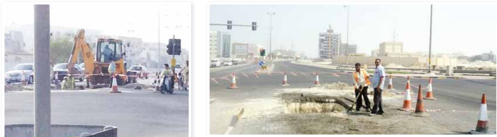
عمال الصيانة أثناء معالجة الحفرة.
