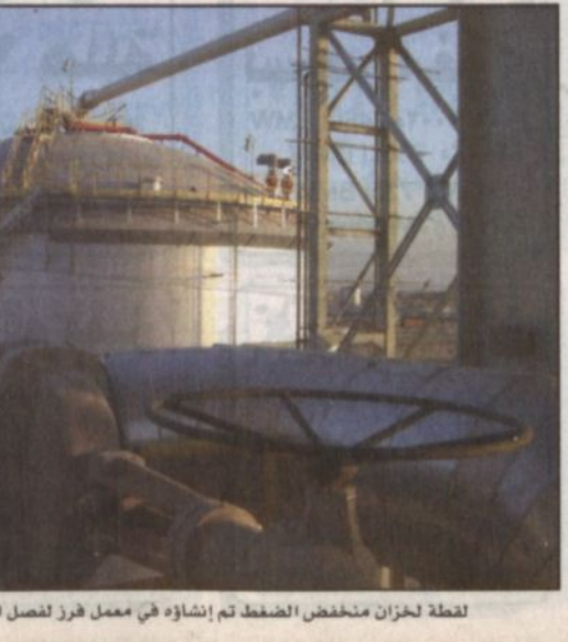
لعة لحران منخفض الضغط تم إنشاؤه في معمل فرز لنصل الغاز من الزيت في حقل القطيف
