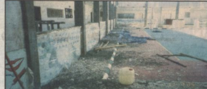
لقطة لأعمال الترميم داخل مدرسة التحفيظ
