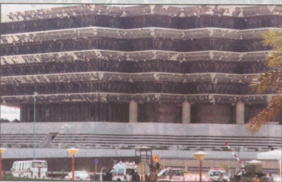
مبنى وزارة الداخلية لدى تعرضه لأعمال الفتن الضالة
