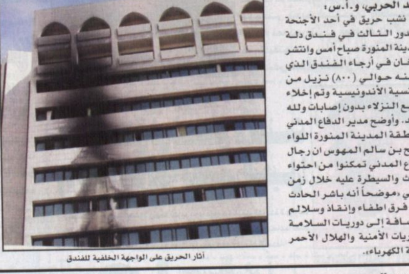
آثار الحريق على الواجهة الخلفية للندق
