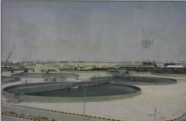
جانب من محطات معالجة مياه الصرف الصحي
