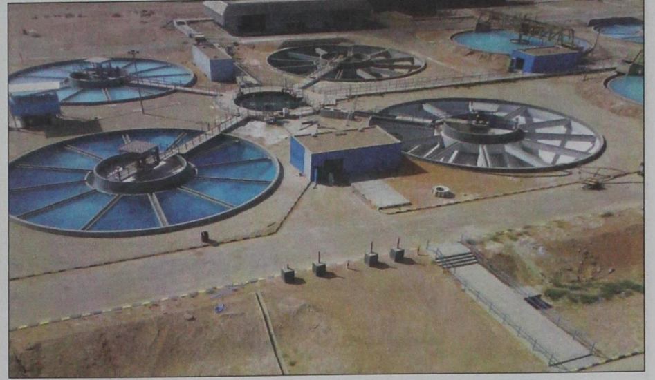
إحدى محطات إنتاج المياه الجوفية
