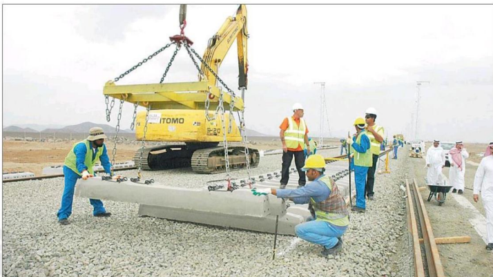
جانب من أعمال المشروع.
