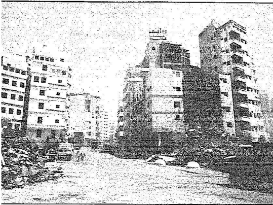
جانب من أعمال الهم للمباني الشمالية للمسجد الحرام
