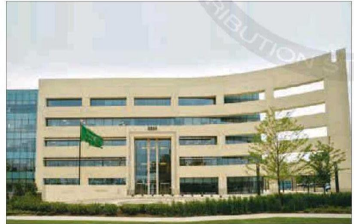
المبنى الجديد للملحقيات الثقافية بواشنطن في مقاطعة فيرفاكس
