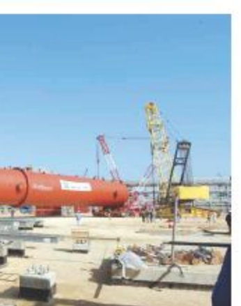
لقطة لعمال تركيب أكبر صهورج فرز للزيت من الماء
