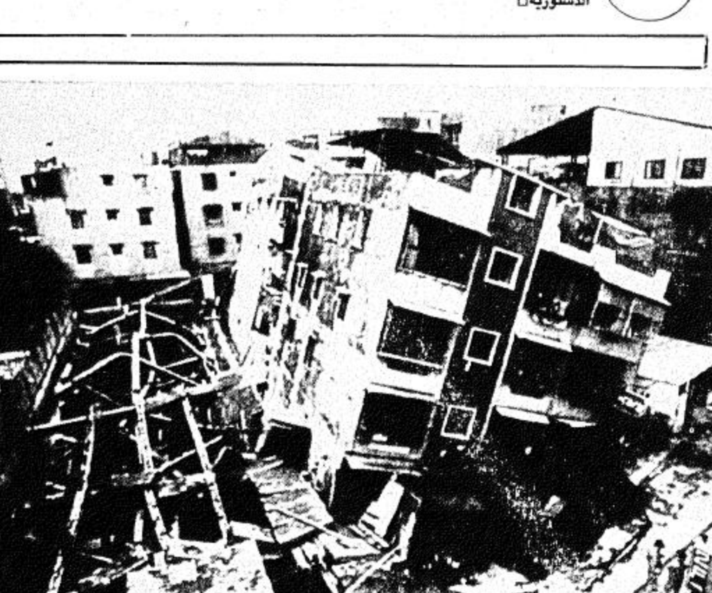
تابيبه - حاياون - اب. تابعة عمارة سكنية مكونة من اربعة طوابق ويسكن بها ٨٢ شخصاً بعد ان حالت على احد جانبيها في احدى ضواحي تاييبه مما اسفر عن اصابة اربعة اشخاص بجراح ويلقى سكانها اليوم في ذلك الانهيار على اعال الانشاء التي تجري في مبني مجاور.
