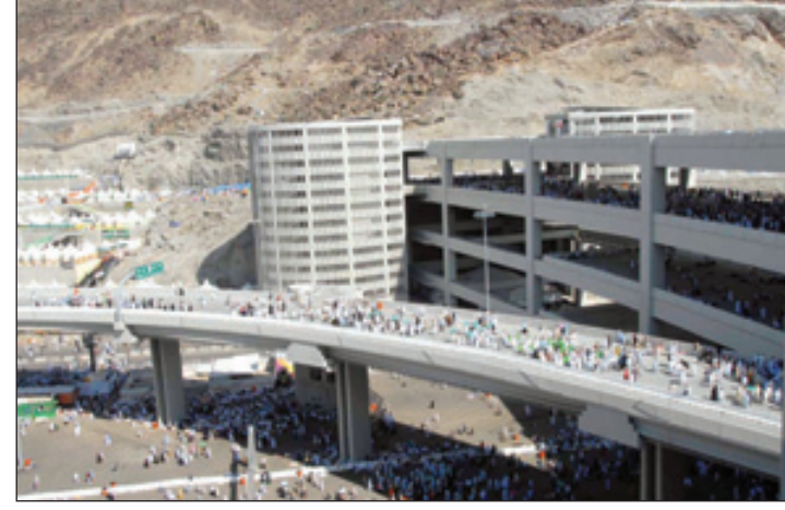
منشأة جسر الجمرات اسهمت بشكل واضح في تسهيل عملية الرمي
