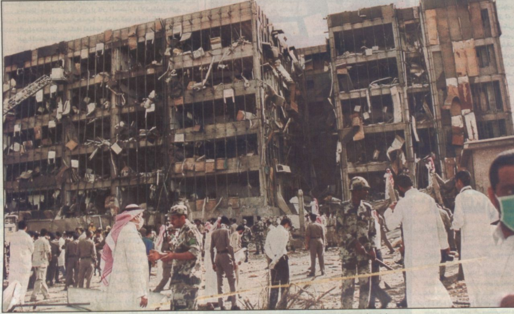
دمار شديد لحق بمبنى المرور والمباني المجاورة في التفجير الإرهابي الجبان (عدسة، يحيى الغبيص - الرياض)
